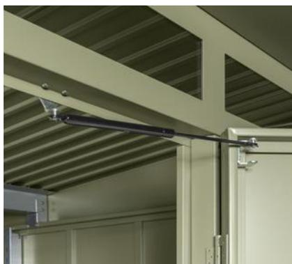
**Türfeststeller mit Gasdruckfeder**
